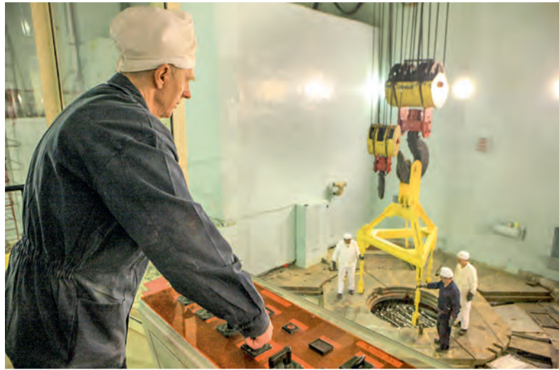
Е. А. Ульянов за пультом управления краном в работах по установке большой защитной плиты реактора
