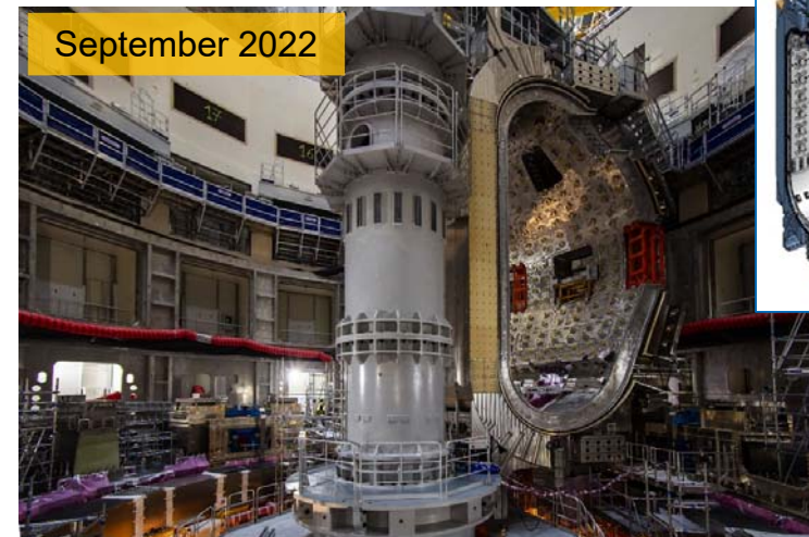
Сектор №6 установлен в шахте с миллиметровой точностью.
