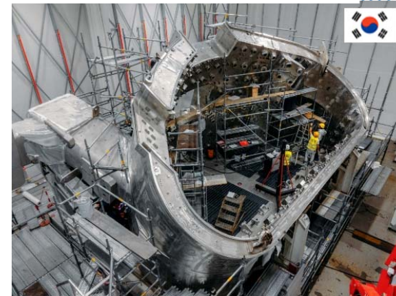
Сектор вакуумной камеры
